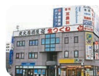
地下鉄福住駅前
